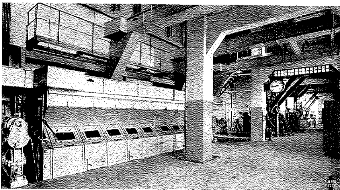
Fig. 24. Le poste de chauffe de la nouvelle installation. Au premier plan, à gauche, la nouvelle chaudière à rayonnement; à sa suite, les chaudières Garbe 3 et 4, puis tout au fond à droite, les chaudières multitubulaires Sulzer 5 et 6.
